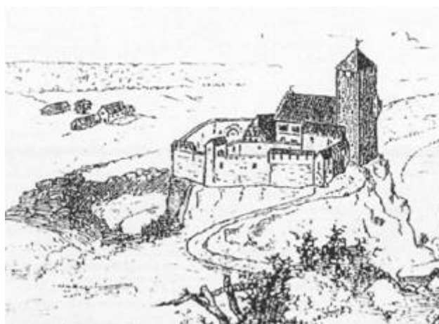
Abbildung 1B. Ansicht von Osten. Um den Burghügel läuft ein teils natürlicher, teil künstlich angelegter Wassergraben. Die Festung wurde 1288 durch König Rudolf von Habsburg zerstört.
